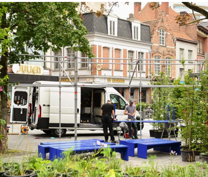
Tests de constructions pour une utilisation temporaire Centrum Kortrijk, 51N4E
